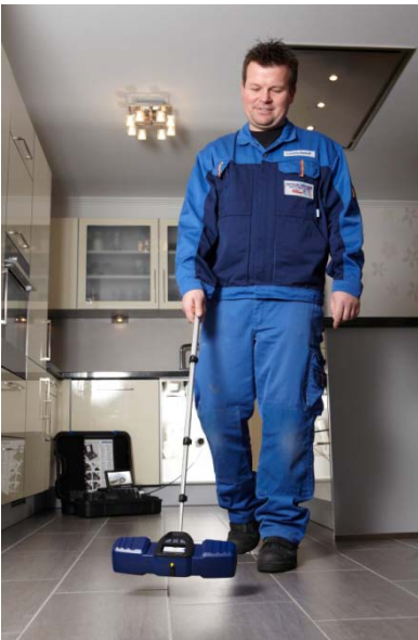
Abb. 4: Lokalisierung des Kamerakopfes im Boden
