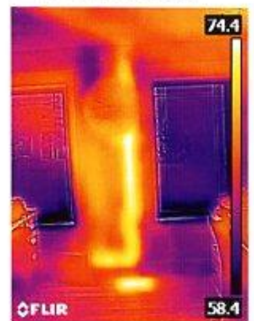
Tubo di scarico caldo nella parete
